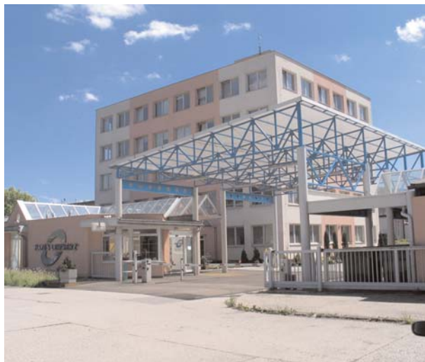
Der Standort im tschechischen Ostrava. Hier steht der Server für alle Videokonferenzen außerhalb der USA
